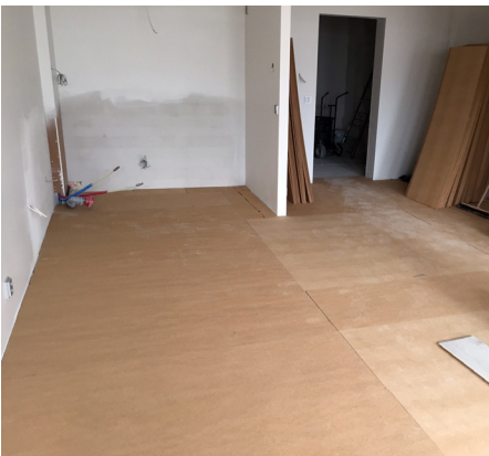
Levyt asennetaan kelluvaksi rakenteeksi. Latominen on nopeaa.
